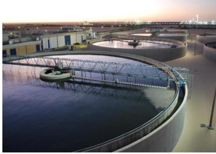
الشكل 1: مرافق معالجة مياه الصرف الصحي في الصليبية بالقرب من مدينة الكويت
